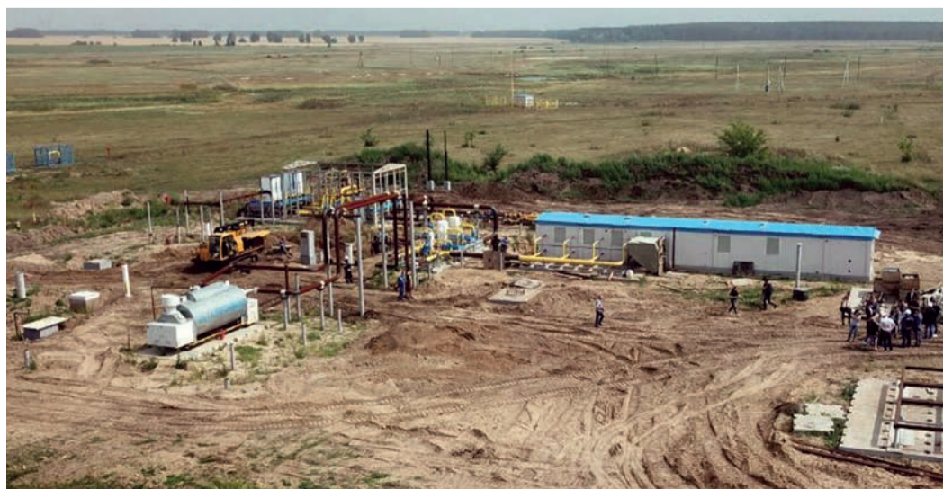
На газораспределительной станции «Ребриха» в Алтайском крае завершаются общестроительные работы
