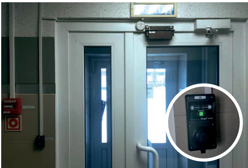
Технология, предложенная сотрудниками Томского ЛПУМГ, не позволяет войти на территорию в состоянии алкогольного опьянения
