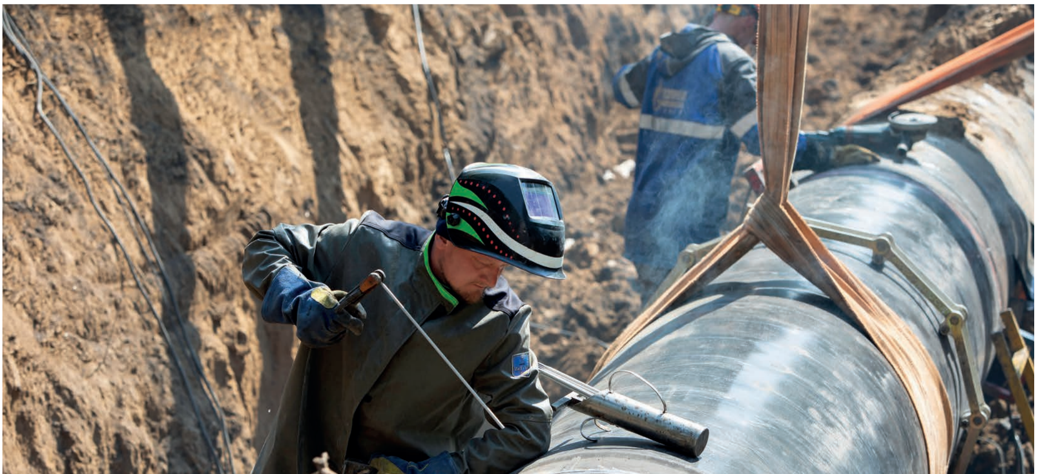
Самый ответственный момент – сварка стыка трубы
